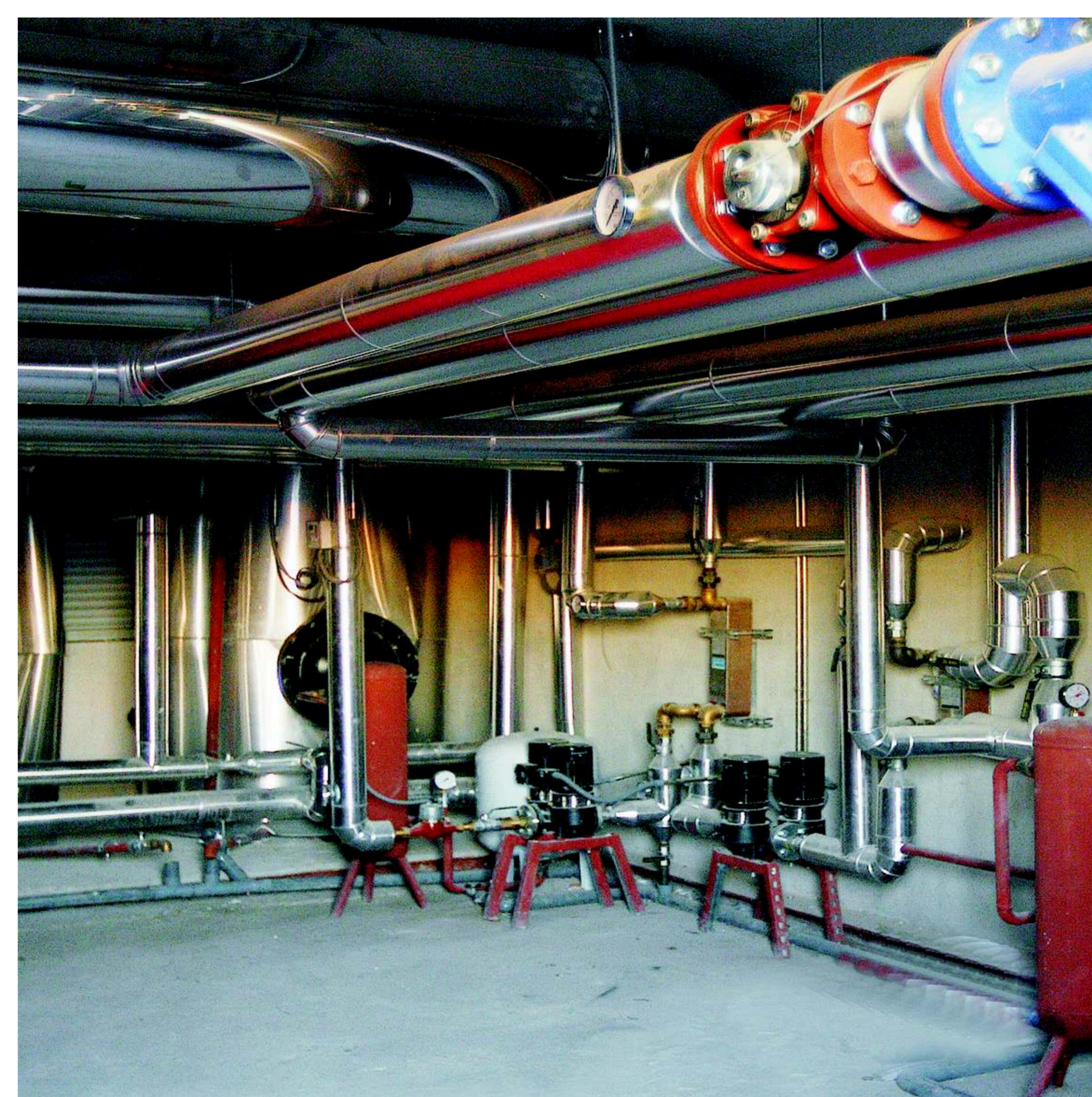
Instalación de calderas de condensación de alto rendimiento
