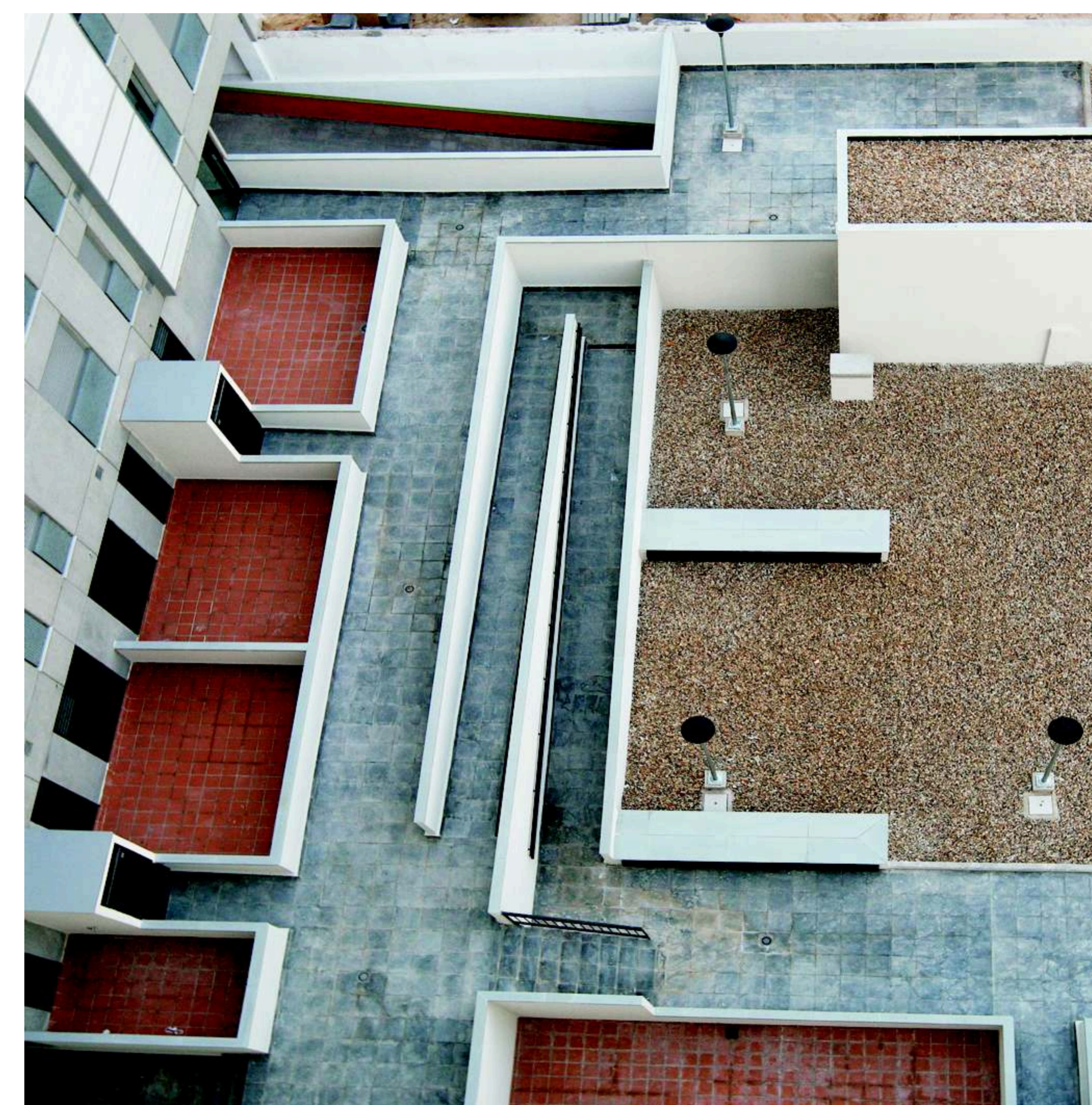
Distribución interior del patio de manzana
